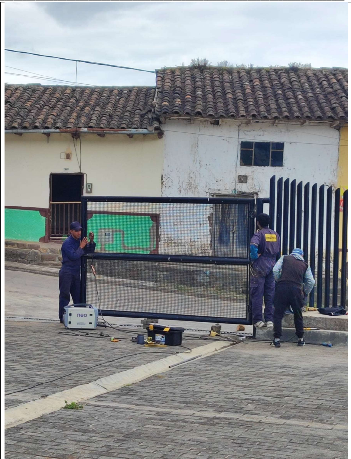
INSTALACION DE LA CERCA ELECTRICA PERIMETRAL PARA INCREMENTO MEJORA DE LA SEGURIDAD DEL CAMPUS DE GUAITARILLA
